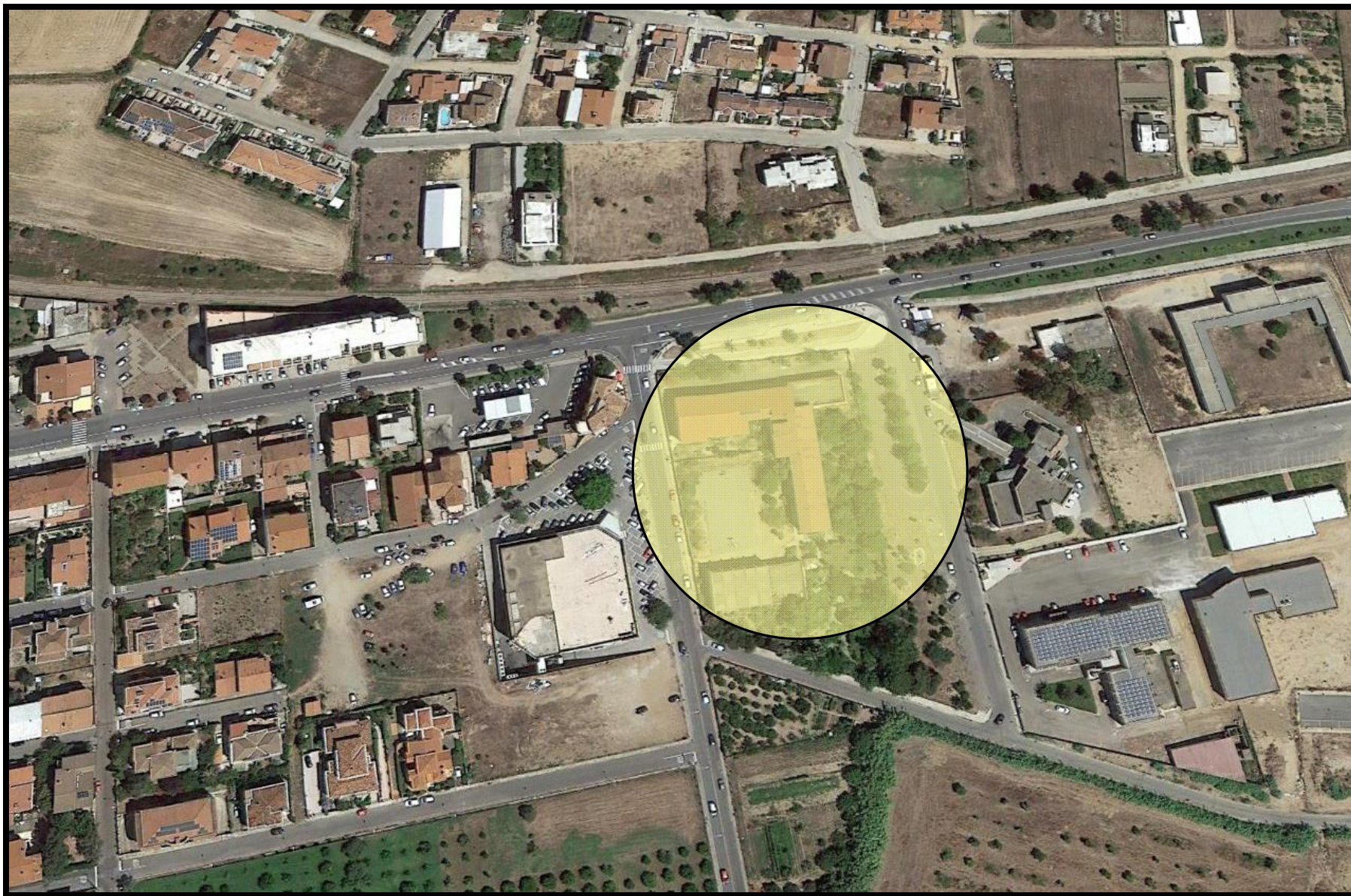
VISTA AEREA CON EVIDENZIATA L'AREA CHE OSPITA L'ISTITUTO SCOLASTICO OGGETTO DEI LAVORI
