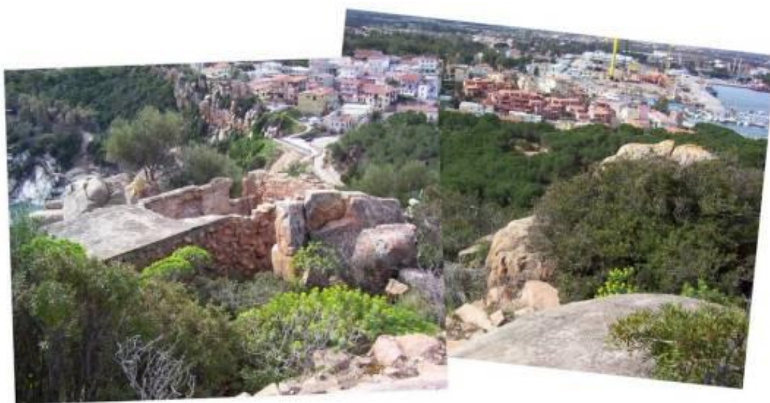
Fig. 31: strutture sul versante meridionale della batteria.
