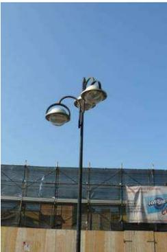
➤ **tipologia 7:** si tratta di globi in policarbonato con sostegno dritto e sbracci perpendicolari al sostegno; è presente in sole due zone ben circoscritte e più precisamente lottizzazione Cattignani e piazza Colombo ad Arbatax; è dotata di lampade a vapore di sodio; l'impianto si presenta in buone condizioni soprattutto quello presente nella lottizzazione; l'unico aspetto negativo è la presenza del vetro curvo non conforme alle linee guida RAS;
