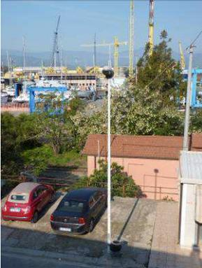
➤ **tipologia 18:** trattasi di punto luce caratterizzato da sostegno dritto ed armatura con vetro piano e trasparente; l'impianto viene esclusivamente utilizzato per l'illuminazione della pista ciclabile presente lungo il Viale Arbatax; si tratta di impianto di recente realizzazione e pertanto in buone condizioni;
